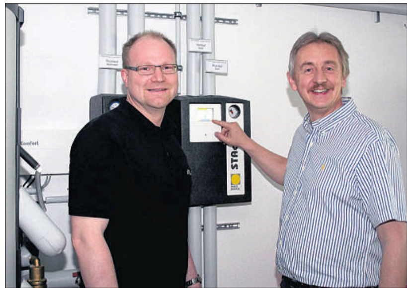
Anlage im Keller: Heiko Kehm (links) lässt sich von Peter Ullrich noch einige Feinheiten zur Steuerung der Photovoltaikanlage erklären. Fotos: Hübele
