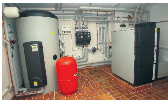
Eine von über 250 gebauten Pellets-Heizzentralen der Firma Ullrich. Foto: nh
