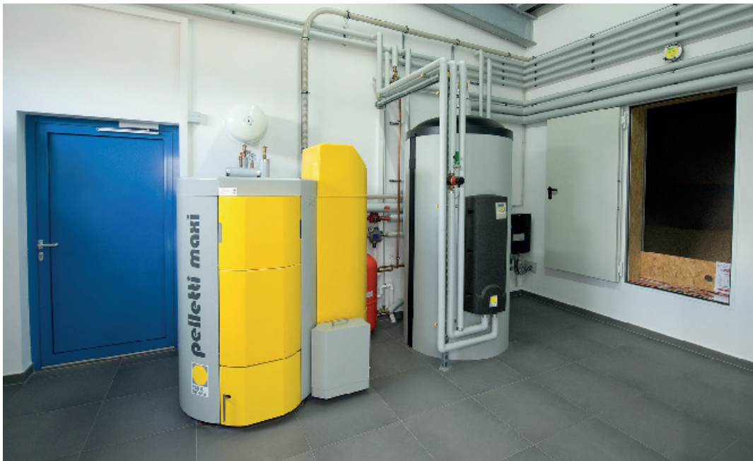
Die Heizzentrale der Firma Ullrich bestehend aus Pelletkessel mit Multi-Energie-Hygiespeicher sowie Solaranlage zur Warmwasserbereitung und Heizungsunterstützung kann in Funktion besichtigt werden. Ebenso ist ein Blick in das Pelletlager möglich.
